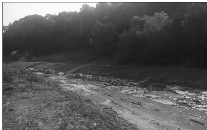
Umocnienie brzegów potoku Kasinka
