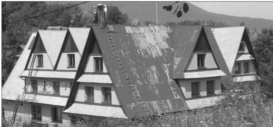
Remont dachu remizy OSP w Olszówce
