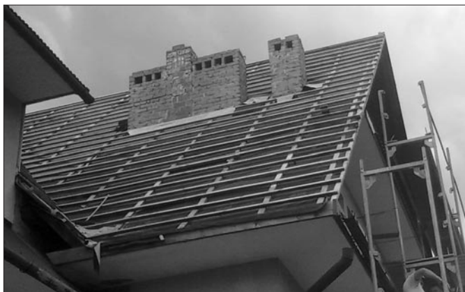
Remont Szkoły Podstawowej nr 3 w Kasince Małej
