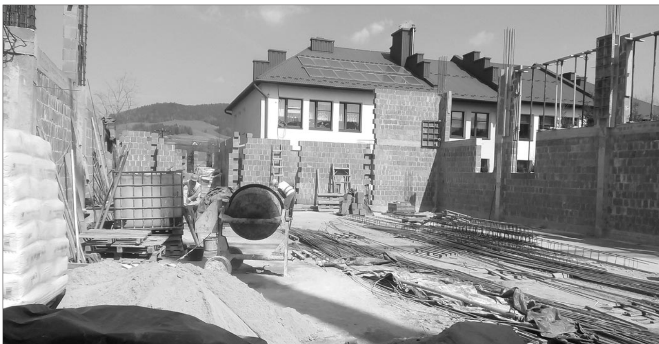
Plac budowy sali gimnastycznej w Mszanie Górnej
