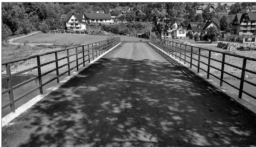
Wyremontowany most w ciągu drogi do osiedla Potok w Kasince Małej
