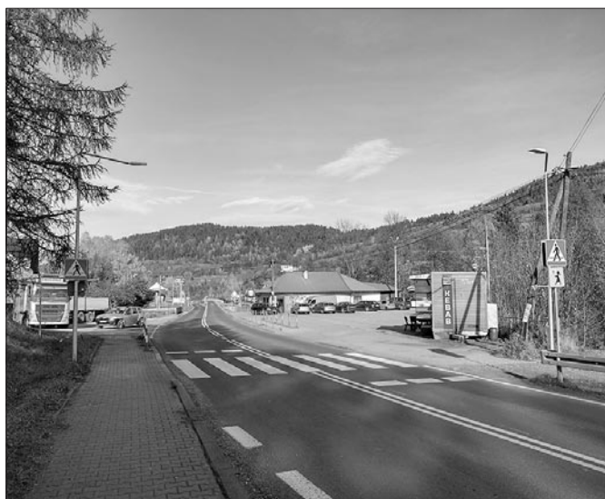
Oznakowane i doświetlone przejście dla pieszych w Lubomierzu
