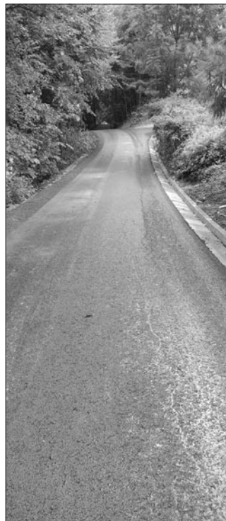
Droga do osiedla Grochale w Kasince Małej
